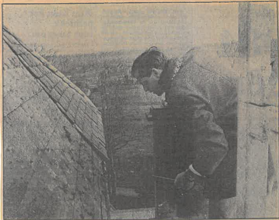
Burgemeester S. Grem van De Beerzen luidde gisteren symbolisch de restauratie van de torenspits in Middelbeers in. Hij deed dat door de versleten leistenen te verwijderen.
